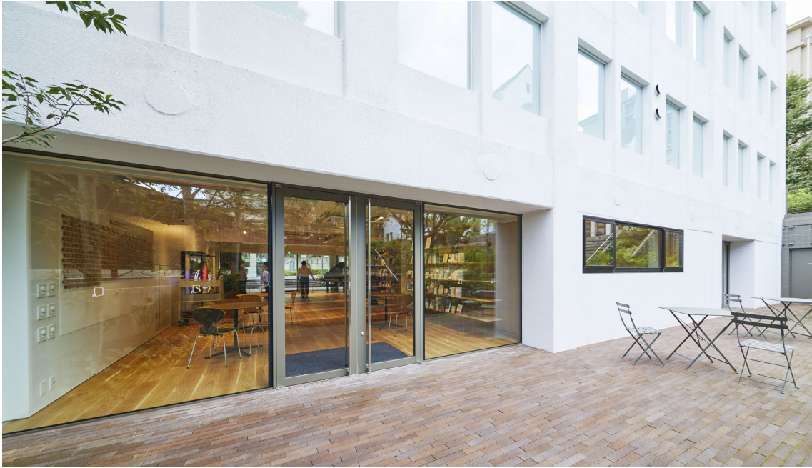
지하 1층 외부 전경
